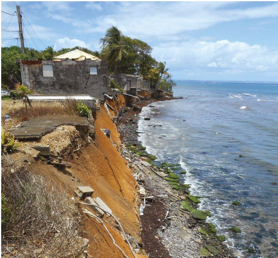
Photo 2 : Guadeloupe quartier de La Poudrière 2016 (© photo : C Claeys).
