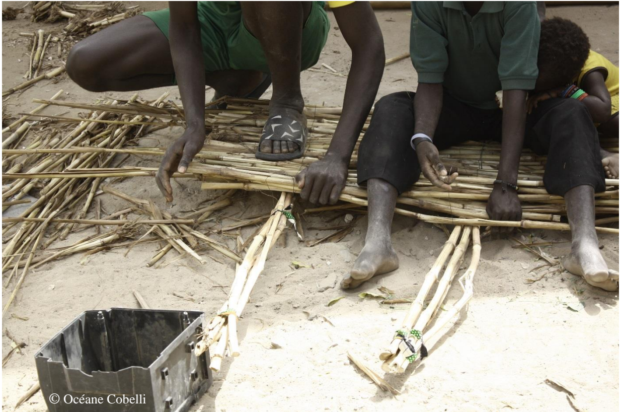
Figure 1 : Photographie illustrant la construction de palissades à partir de tiges de Mathie
