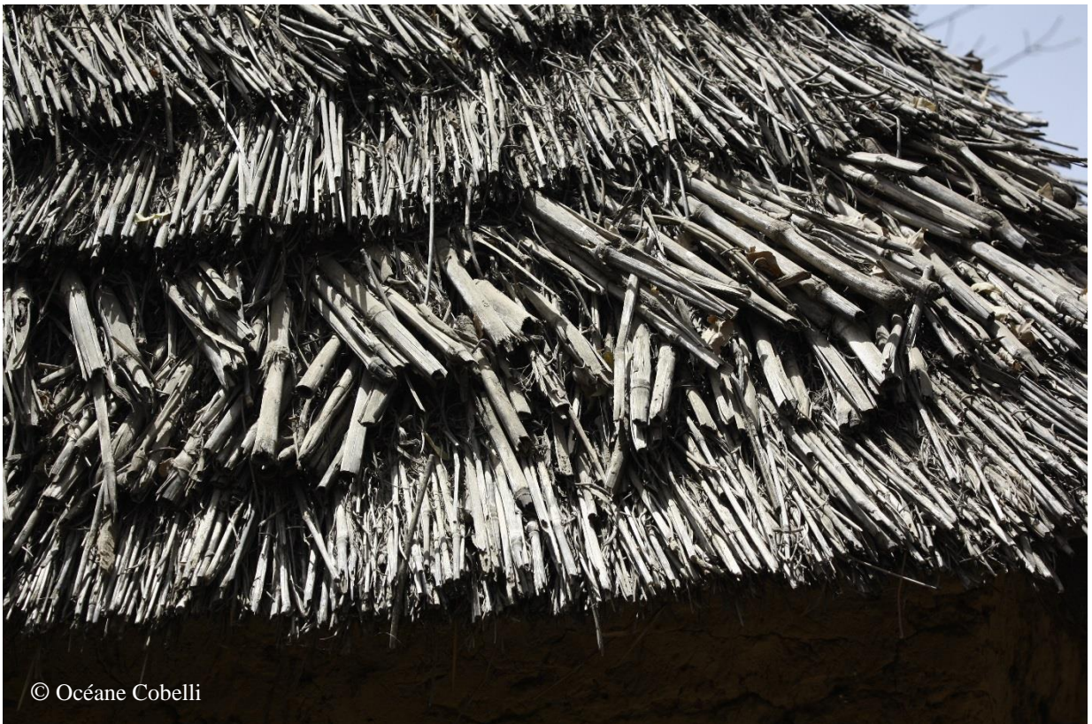
Figure 2 : Photographie illustrant l'utilisation du mil comme matériau pour la construction des toits
